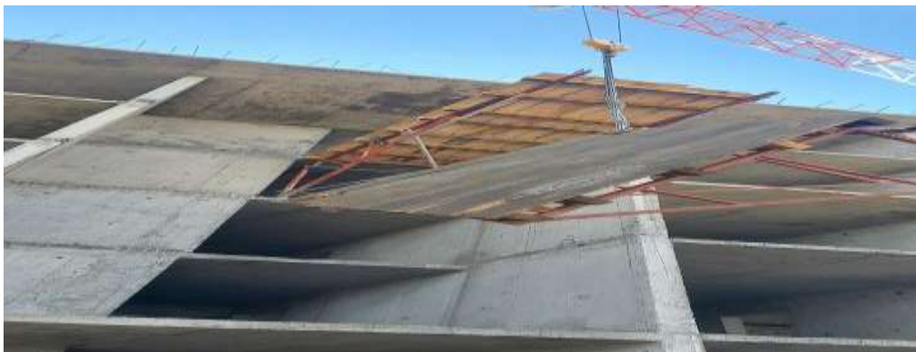
Resim 2. Beton kalıp sökümü iş kazası
