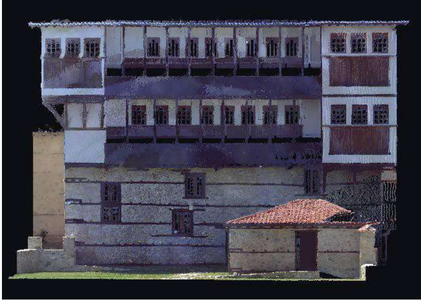
Şekil 2. Tsiatsiapa tarihi bina - Ön cephe 3B veri bulutu
