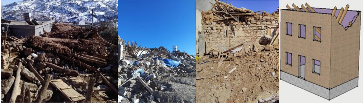
Şekil 7. Ağır toprak damlarda meydana gelen çökmeler
