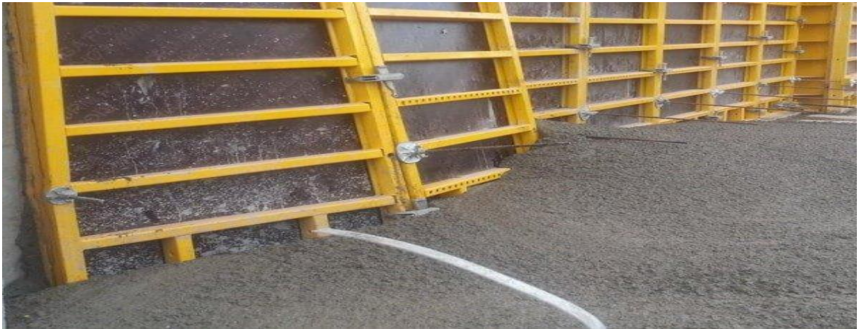
Şekil 7. Beton Dökümü Sırasında Kalıbın Açılması
