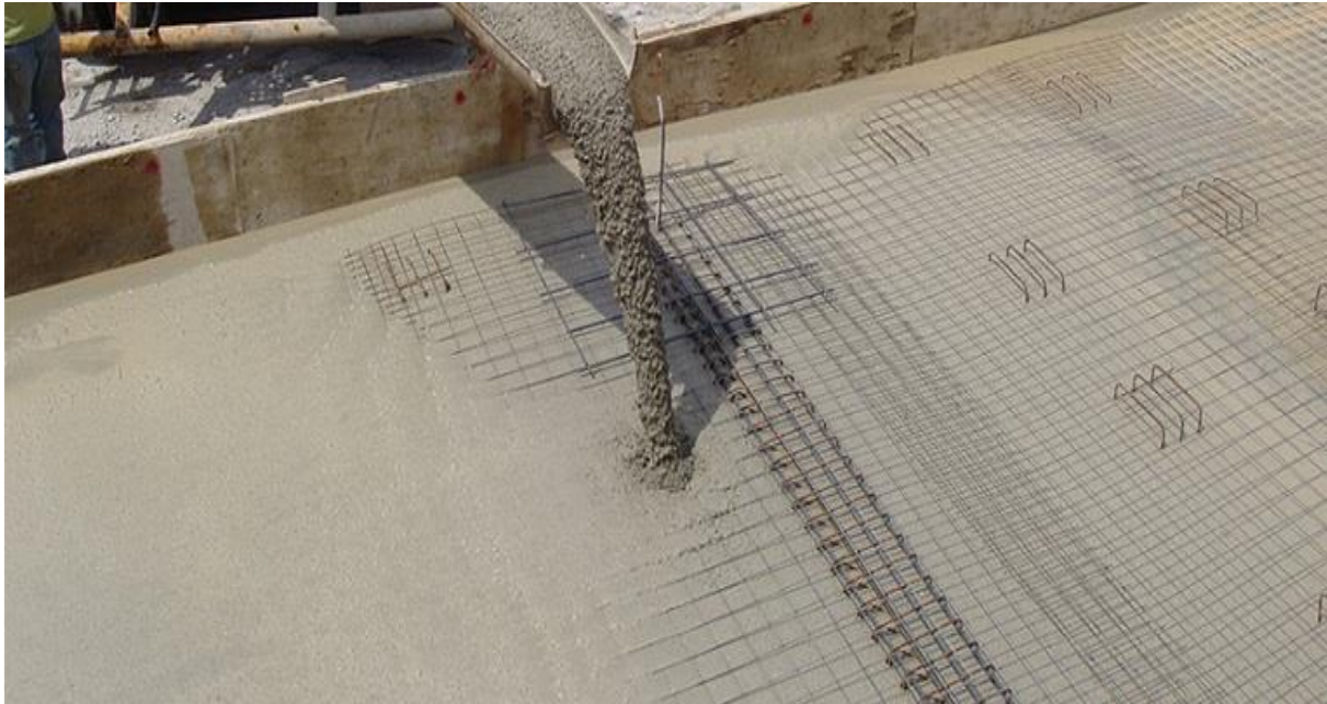
Şekil 1. Viskozitesi Yüksek Kendiliğinden Yerleşen Beton
